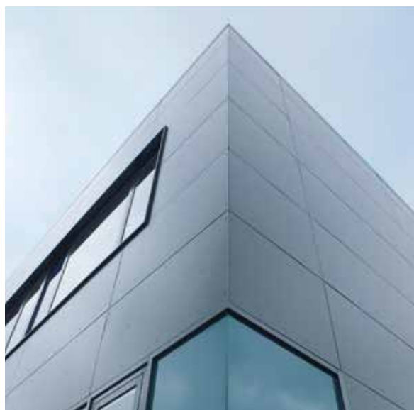
Пример вентилируемого фасада: Образовательный центр, Нидерзаксверфен ©Dach Schneider Weimar GmbH
